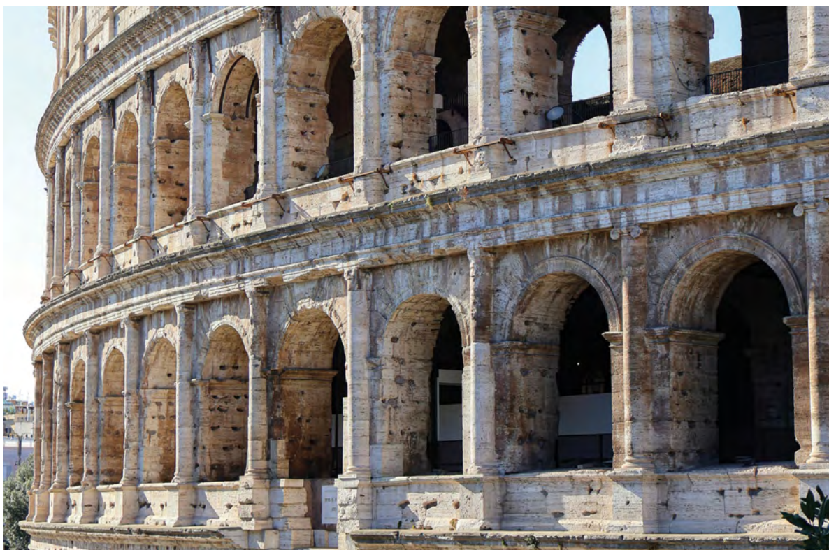
Koloseum, ikoniczna budowla starożytnego Rzymu, do dziś zachwyca swoją architekturą. Dzięki zastosowaniu łuków arkadowych amfiteatr osiągnął nie tylko imponujący wygląd, ale również przetrwał próbę czasu
