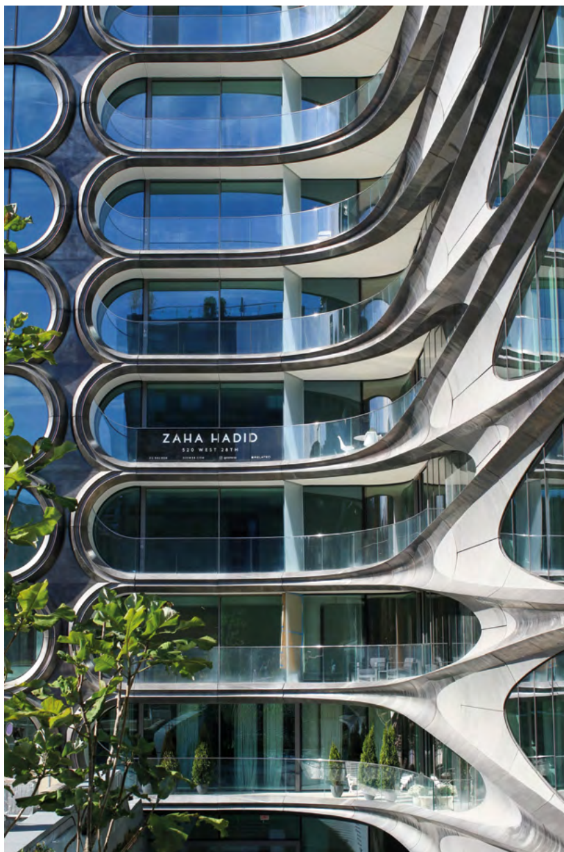
Fasada apartamentowca 520 West 28th – pierwszego projektu Zaha Hadid Architects w Nowym Jorku
